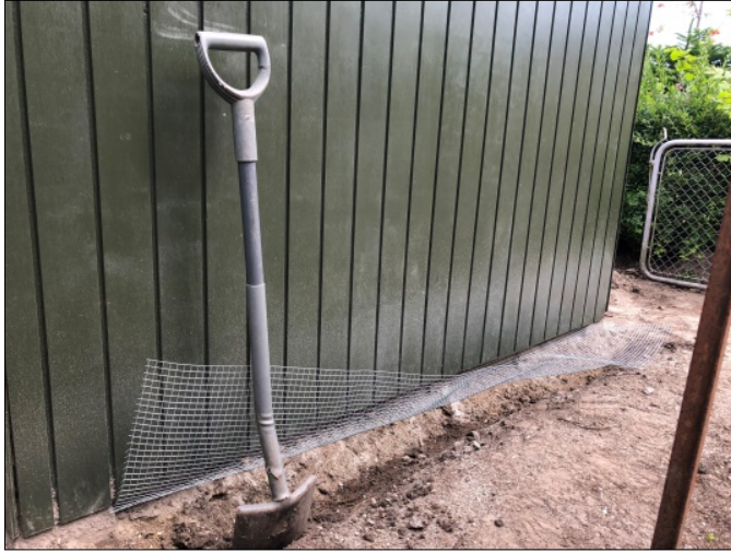
Nettet skal fæstnes nederst på terrassen eller bygningen og et spadestik ned i jorden. Resten af nettet lægges vinkelret ud og dækkes med jord eller græstørv
