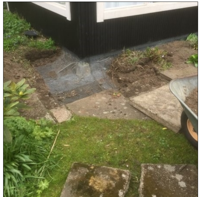
Rottesikring med trådnet fastgjort på bygningens nederste del og herefter lægges fliser ovenpå
