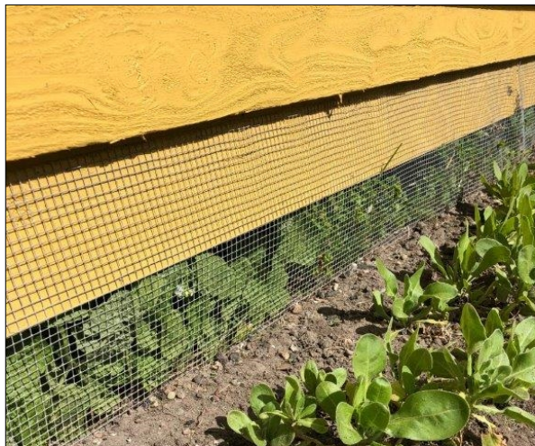
Nettet skal fæstnes nederst på terrassen eller bygningen og et spadestik ned i jorden. Resten af nettet lægges vinkelret ud og dækkes med jord eller græstørv
