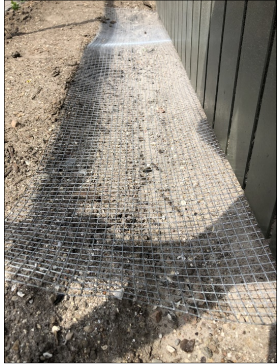
Nettet skal fæstnes nederst på terrassen eller bygningen og et spadestik ned i jorden. Resten af nettet lægges vinkelret ud og dækkes med jord eller græstørv
