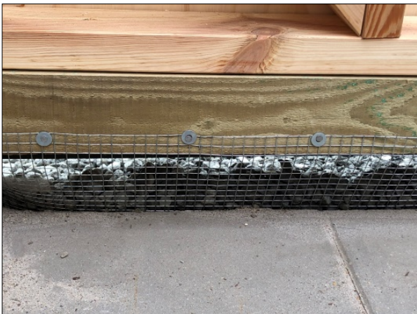
Rottesikring med trådnet fastgjort på bygningens nederste del og herefter lægges fliser ovenpå
